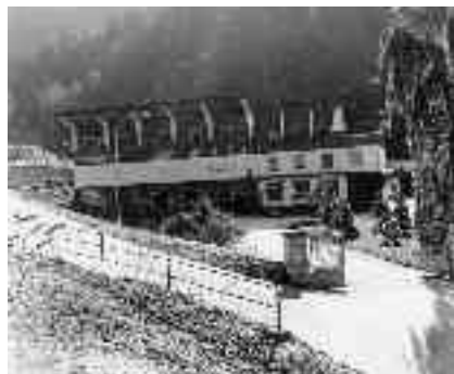
Figura Number range Figura: Centrale Castelpietra
